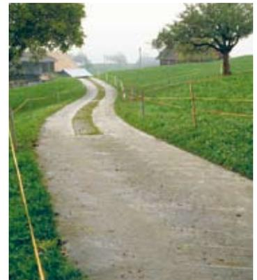
Der Verlauf dieses Flurwegs, der sich weich dem Gelände anschmiegt, wurde beim Einbringen des Hartbelags nicht verändert. Trotz konstanter Wegbreite und vollflächigem Beton, gefolgt von Betonfahrspuren, als Wegoberfläche entsteht kein Geometrisierungseffekt. Kanton Obwalden (ViaStoria/Arne Hegland). Vgl. S. 61.
