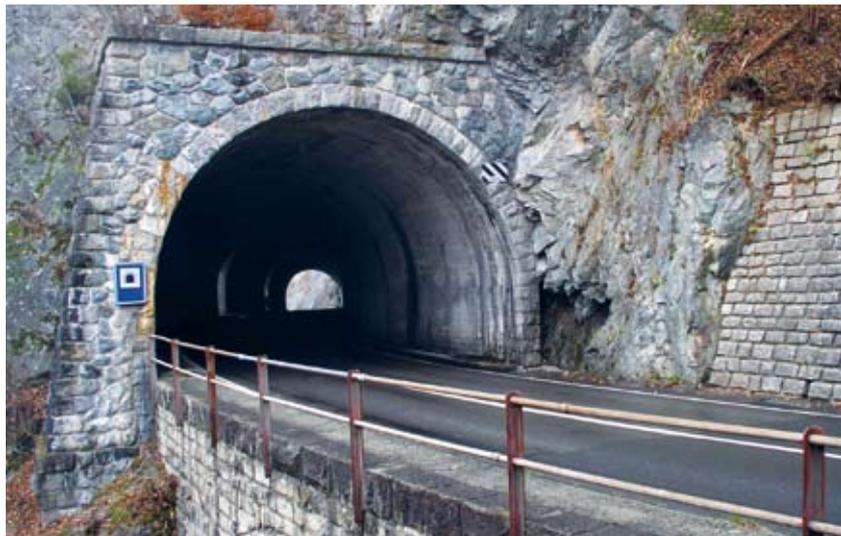
Erneuerung durch zeitgenössische Mittel: Ostportal des 1940 erstellten Wylertunnels an der Sustenpassstrasse nach der Erneuerung 2006/07 mit sorgfältig durchgestaltetem kreisförmigem Betongewölbe und Restbestand des ursprünglichen Portals (ViaStoria/Guy Schneider).
