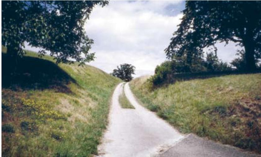
Der trocken verlegte Steinsatz einer rollierten Böschung schützt diese vor Erosion. Bei Steingletscher an der Sustenpassstrasse BE (ViaStoria/Guy Schneider).
