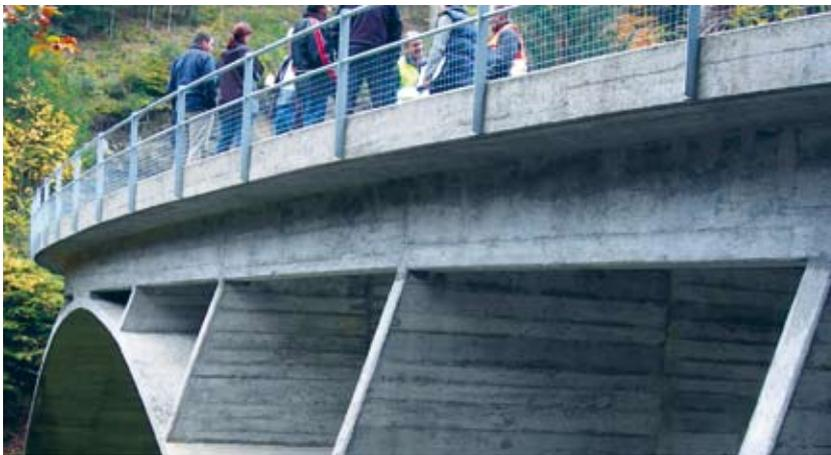
Brücke mit instand gesetztem Rohrgeländer, das nicht den heutigen Sicherheitsnormen entspricht. Das zusätzliche Drahtgitter im unteren Bereich bildet die Absturzsicherung für Personen. Zusammen mit dem Schrammbord ist in dieser Situation auch die Anprallsicherheit gewährleistet. Schwandbachbrücke von Robert Maillart bei Hinterfultigen BE (EPFL/ Eugen Brühwiler).
