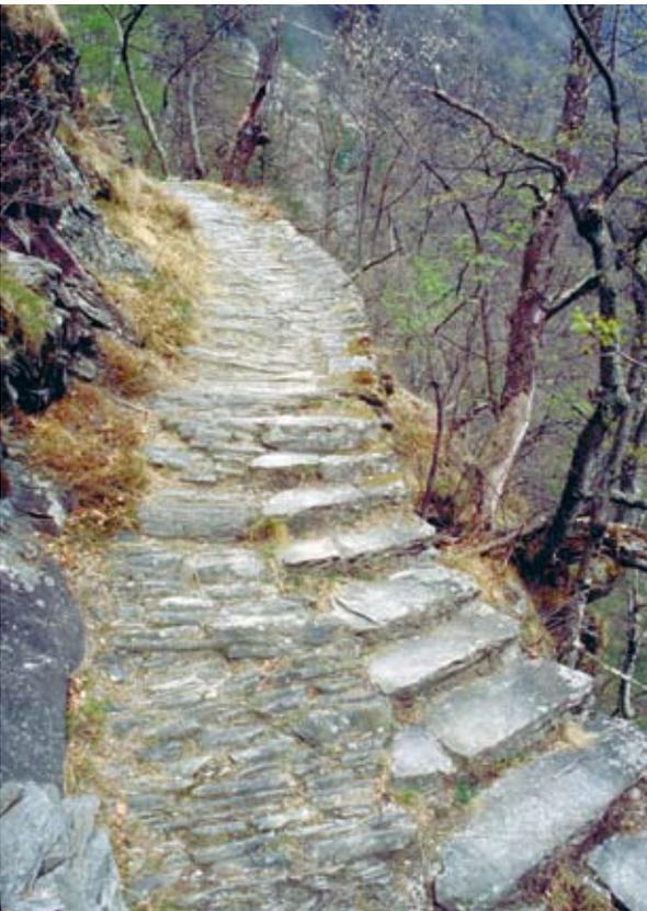
Aufwändig gebauter Saumpfad in einer Steilstufe: Er besitzt ein Reihensplaster mit hochkant gestellten Platten und Trittstufen aus Steinplatten. Zwischen Promontogno und Soglio GR (ViaStoria/Guy Schneider).
