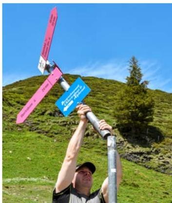
Abb. 15 Wegweisermontage mit Kopfwechselsystem
