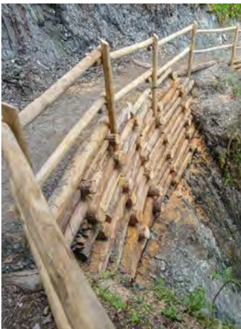
Fig. 101 Palificata di sostegno
