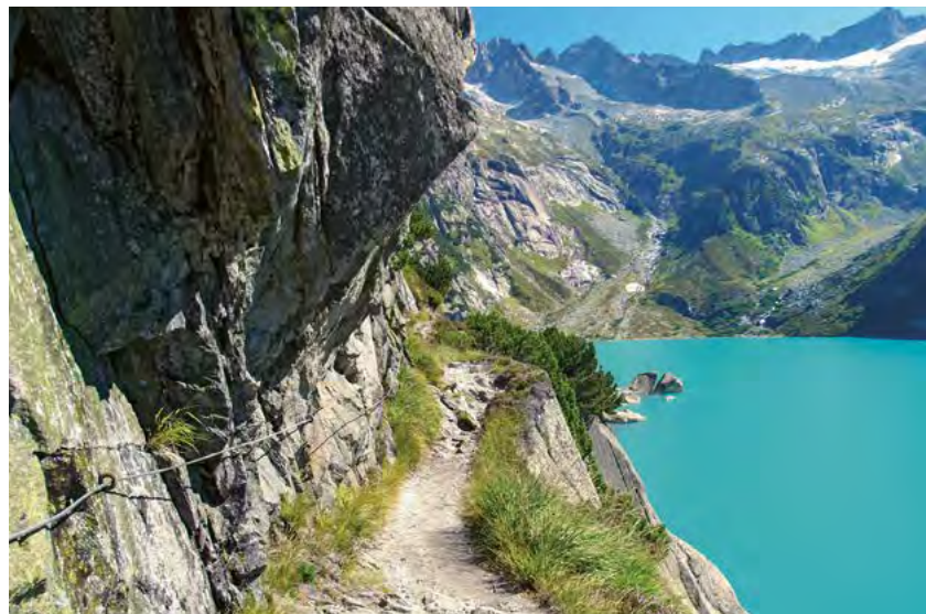
Fig. 18 Sezione tipo nella roccia. Piano di calpestio con lieve pendenza verso monte. Occorre garantire sufficiente libertà di movimento all'altezza delle spalle.
