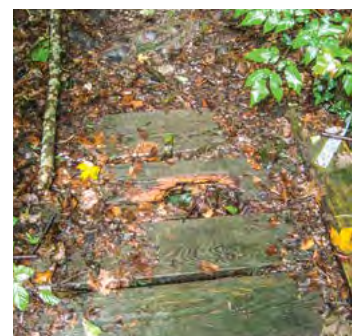
Fig. 111 Le foglie morte umide fanno marcire gli elementi in legno.
