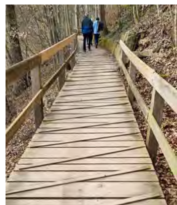
Fig. 70 Piano di calpestio antiscivolo con listelli di legno fissati trasversalmente
