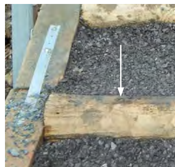
Fig. 81 Gradino con fori trapanati per il fissaggio dei ferri di armatura (castagno poco scivoloso)
