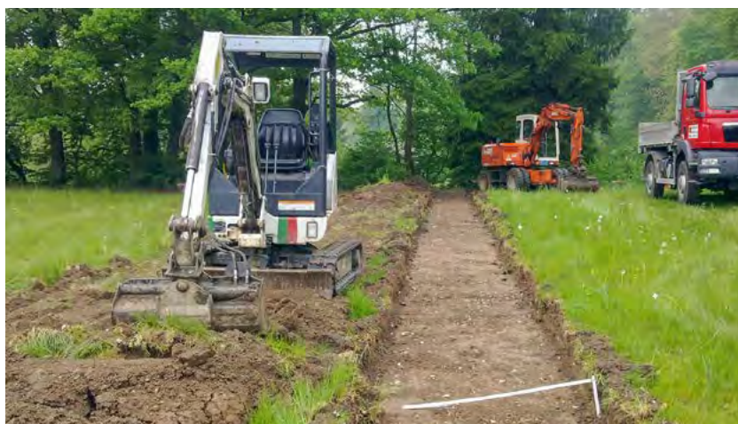
Fig. 22 Lavori di scavo su un terreno pianeggiante
