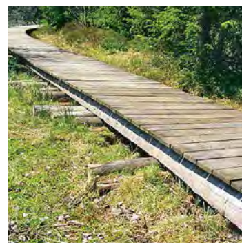
Fig. 77 Passerella su travi trasversali
