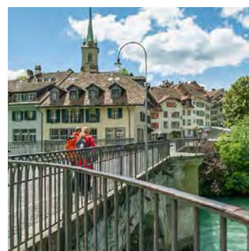
Fig. 88 Parapetto a ringhiera
