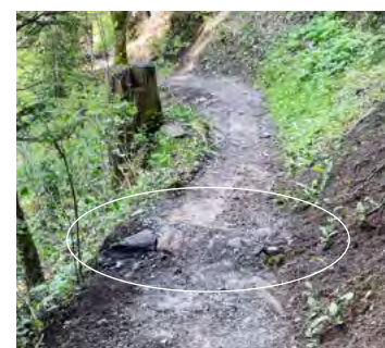
Fig. 53 Riporto di ghiaia consolidato con pietre
