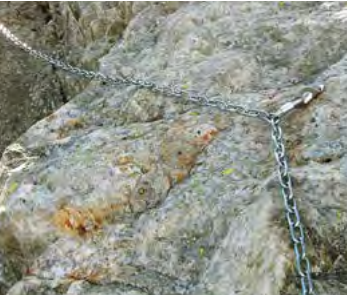
Fig. 90 Corrimano realizzato con una catena zincata
