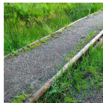
Fig. 20 Piano di calpestio di un camminamento ricoperto di pietrisco. La durabilità dei camminamenti aumenta notevolmente se il legno è ricoperto anche lateralmente con del materiale di sterro.
