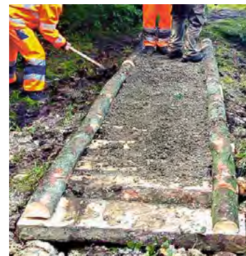
Fig. 19 Ricoprimento del camminamento con terra e pietrisco
