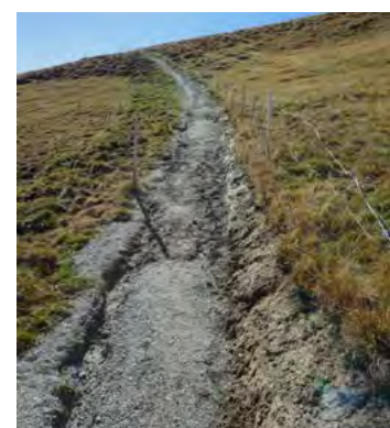
Fig. 28 Erosione estesa su un pendio
