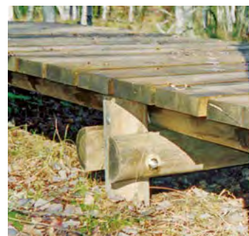
Fig. 76 Passerella su pile
