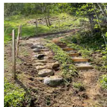
Fig. 27 Separare i tracciati su tratti brevi in corrispondenza di punti con scarsa visibilità aumenta la sicurezza degli escursionisti.
