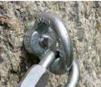
Fig. 91 Ancoraggio corretto della catena
