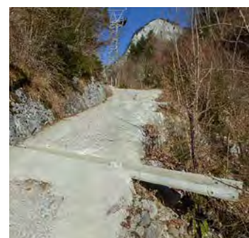
Fig. 4 Intervento che altera gravemente il paesaggio naturale.
