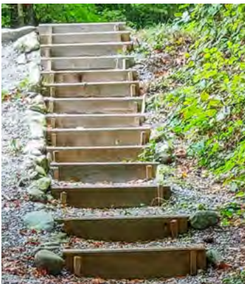
Fig. 79 Scala di legno con rinterro
